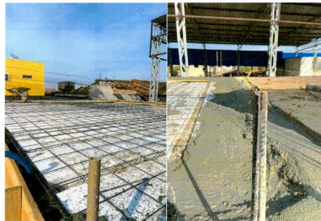
Foto 03: Montagem e Concretagem da Laje
