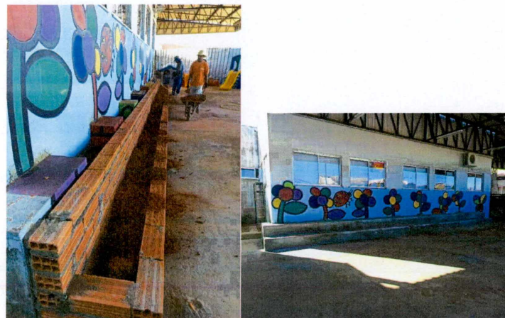
Foto 01: Assentamento de alvenaria e concretagem do banco
