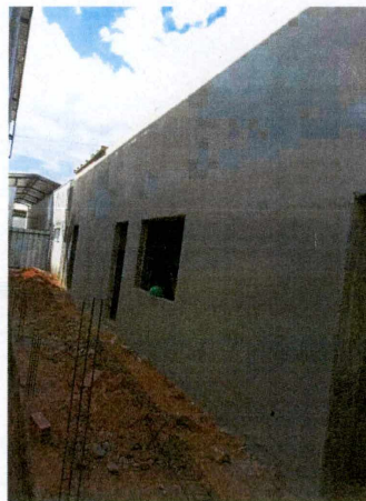
Foto 05: Emboço e Reboco externo
