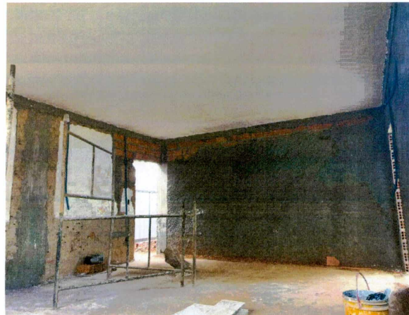
Foto 02: Assentamento de Gesso no teto
