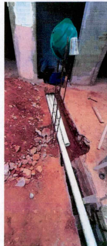
Foto 02: Passagem da tubulação de água pluvial
