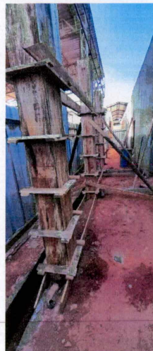
Foto 03: Forma e escoramento dos pilares do corredor
