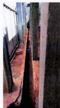
Foto 05: Impermeabilização da vala e Concretagem dos Pilares do corredor
