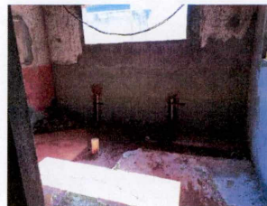
Foto 04: Montagem da Tubulação de esgoto do Fraldário 1
