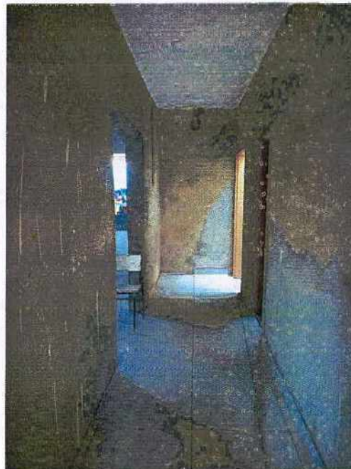
Fotos 03 e 04: Execução de reboco na alvenaria e emassamento da laje.
