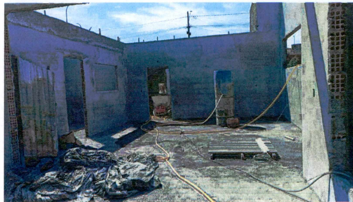
Foto 4: Reboco e contrapiso.
