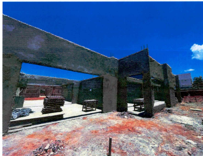
Foto 3: Reboco e contrapiso.
