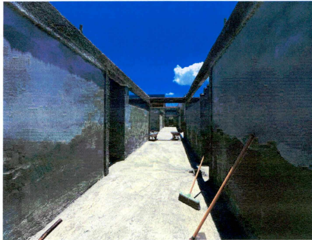
Foto 2: Reboco e contrapiso.
