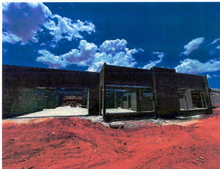
Foto 5: Reboco e contrapiso.
