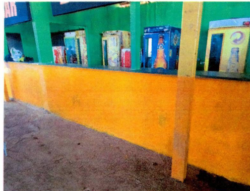
Figura 1: Restauração do balcão do bar e ampliação
