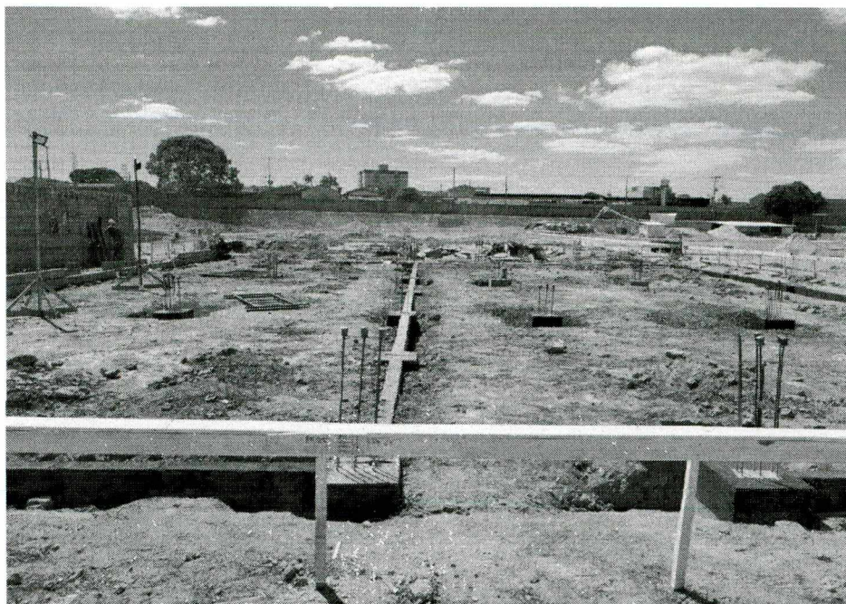
FOTOS 5 E 6 – JUNTA C: Desforma e impermeabilização de blocos e baldrame
