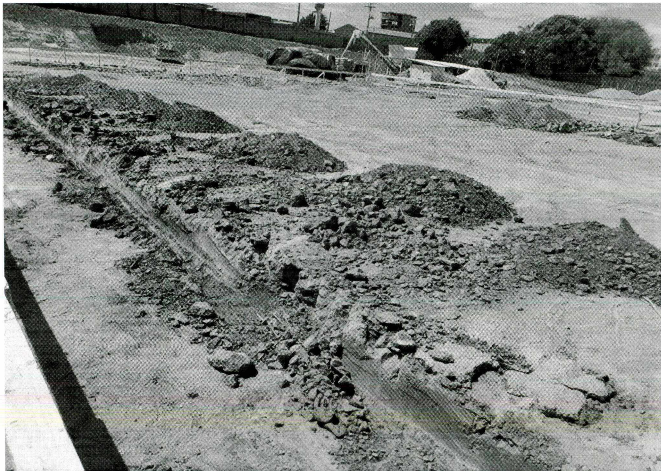
FOTO 9 – JUNTA E: Escavação de baldrame.
