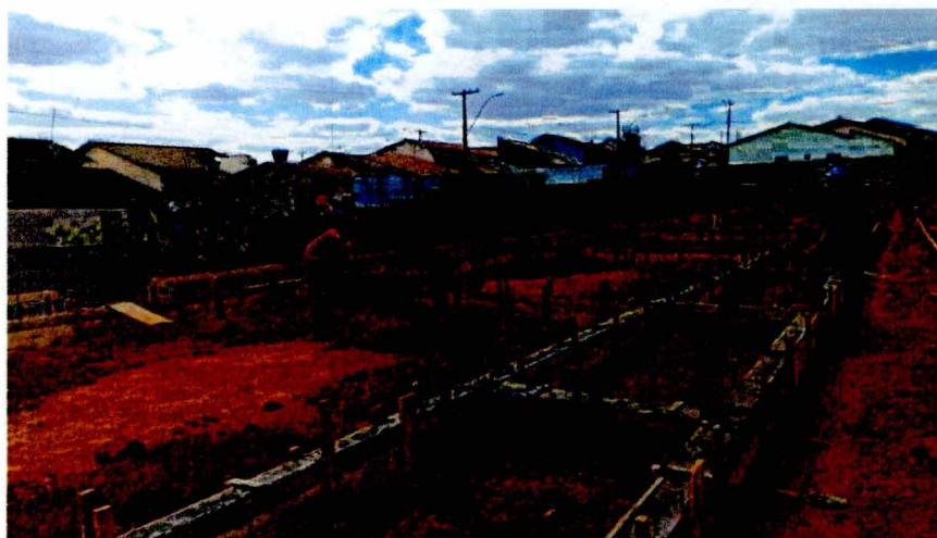
Foto 04: Execução da viga baldrame
