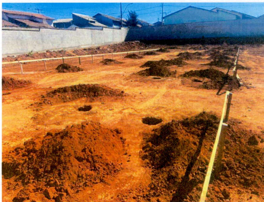
Foto 01: Perfuração de estacas
