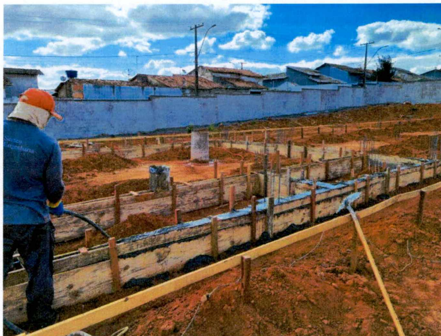
Foto 02: Concretagem viga baldrame
