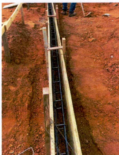
Foto 03: Execução das fôrmas da viga baldrame
