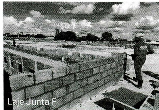
FOTOS 25 a 28: concretagem da laje; execução de alvenaria da platibanda.
