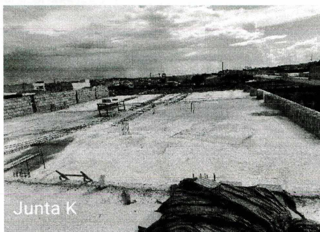
FOTOS 45 a 47: Execução de alvenaria de primeira e segunda etapa; concretagem da laje e execução de alvenaria da platibanda.
