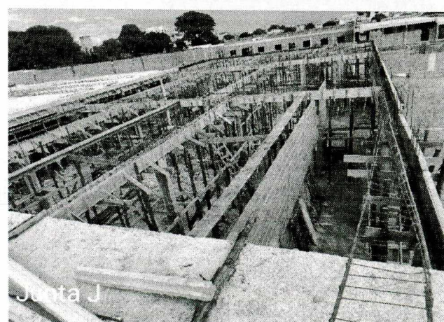
FOTOS 41 a 44: concretagem de blocos e baldrames; execução de alvenaria de primeira e segunda etapa; montagem do escoramento e montagem das vigas de cobertura.
