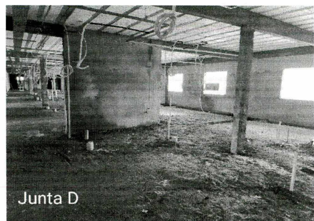
FOTOS 18 a 21: Execução de reboco interno; execução de instalações hidrossanitário; execução de alvenaria da calha; infra de instalações elétricas.
