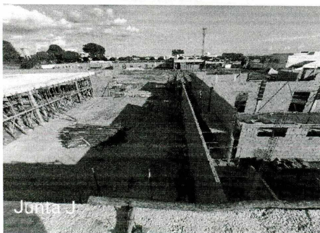
FOTOS 41 a 44: concretagem de blocos e baldrames; execução de alvenaria de primeira e segunda etapa; montagem do escoramento e montagem das vigas de cobertura.
