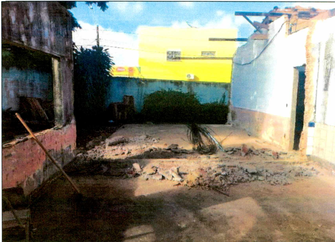
Foto 02: Demolição manual de alvenaria danificada
