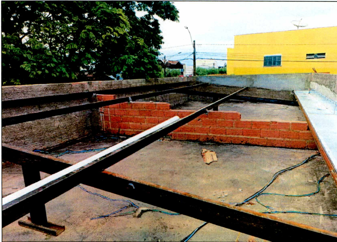
Foto 05: Estruturação do telhado para cobertura em fibrocimento
