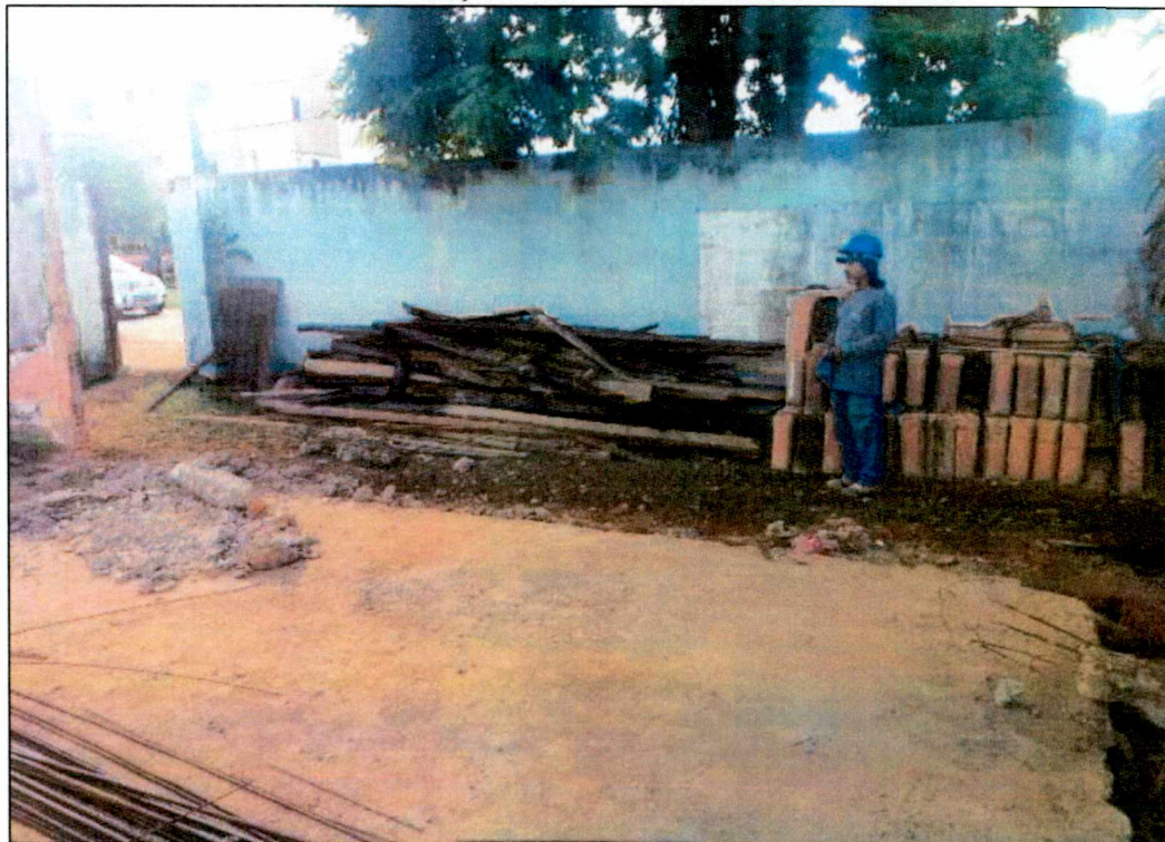
Foto 01: Demolição manual de alvenaria danificada
