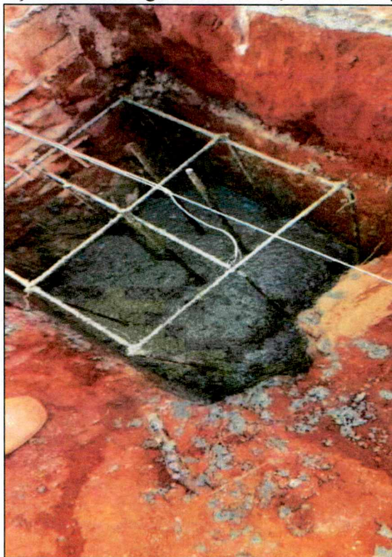
Foto 04: Armação e concretagem de estacas, blocos e vigas baldrames
