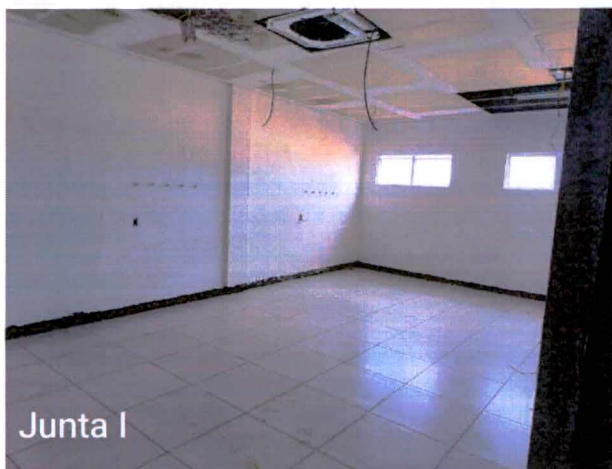
Fotos 20 a 21: Execução de revestimento cerâmico de piso e paredes;
