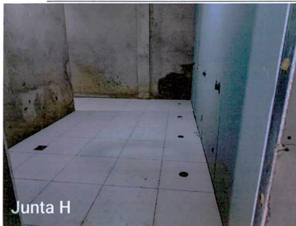
Fotos 20 a 21: Execução de revestimento cerâmico de piso e paredes;
