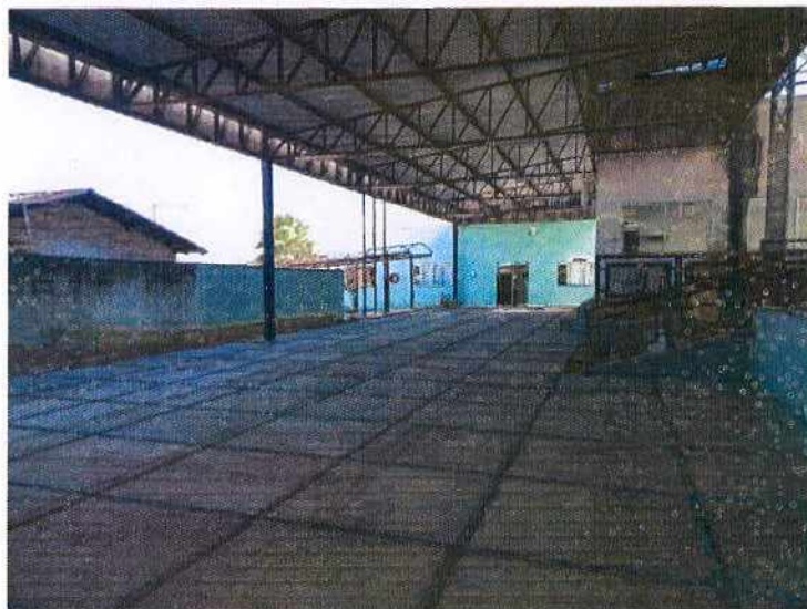
Foto 01: Execução das juntas da granitina
