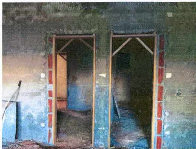
Foto 07: Instalações de Portais da cozinha
