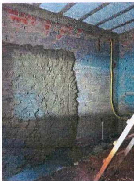
Foto 03: Execução de reboco da cozinha
