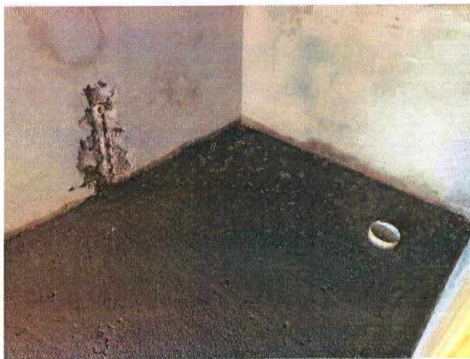
Foto 05: Execução de contrapiso da cozinha
