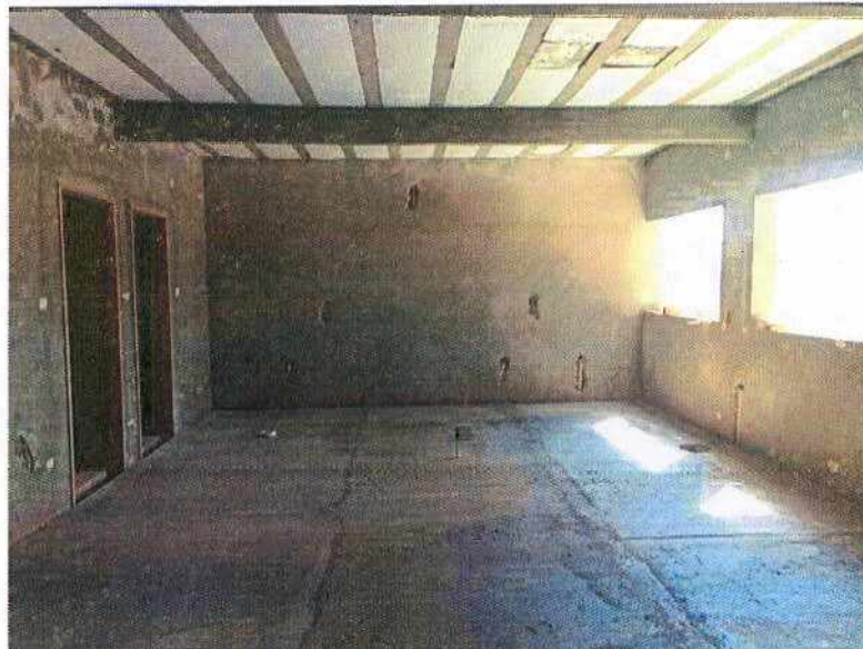
Foto 08: Requadro de janelas, reboco e contrapiso da cozinha
