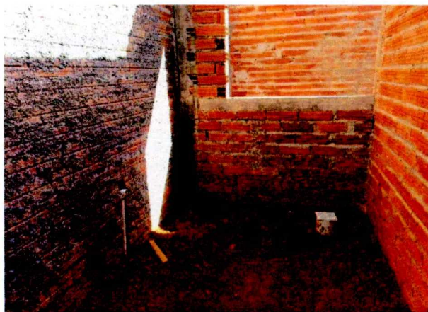
Foto 03: Instalação das tubulações de esgoto
