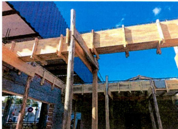
Foto 04: Escoramento da laje e chapisco da cozinha
