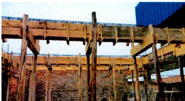
Foto 02: Montagem de formas para as vigas aéreas
