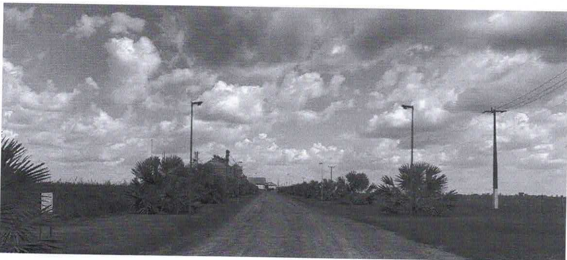
Iluminação dos caminhos de serviço da Empresa Agro Cangaia Armazéns Ltda
