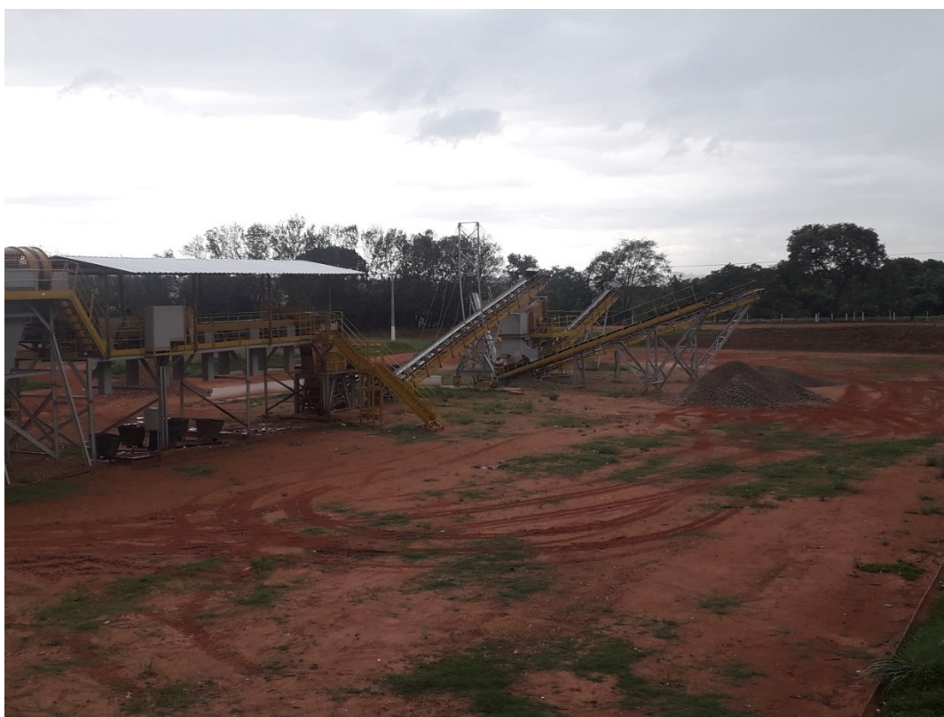
Figura 27 - Usina de reciclagem de entulhos
