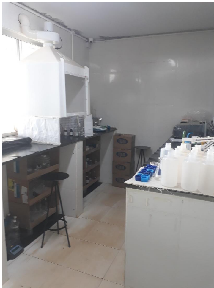
Figura 36 – Estruturas do laboratório da ETA (III)
