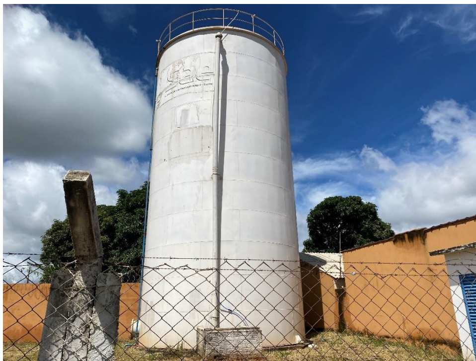
Figura 44 – Reservatório do Pontal Norte (Sistema Sede)
