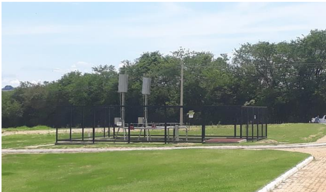
Figura 102 – Queimador de gases ETE Catalão (Sistema Sede)
