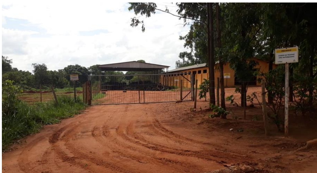
Figura 123 – Galpão para recebimento de pneus
