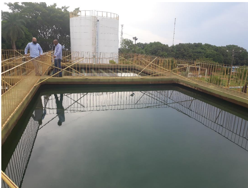
Figura 30 – Decantadores ETA convencional (Sistema Sede)
