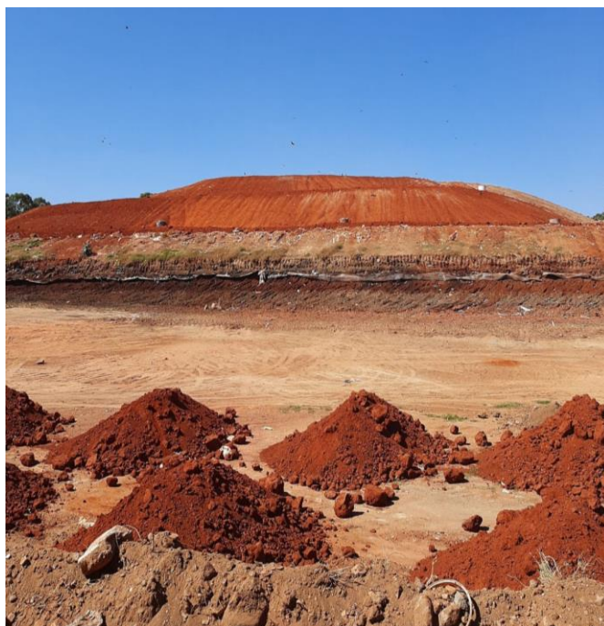
Figura 113 – Taludes do aterro (II)
