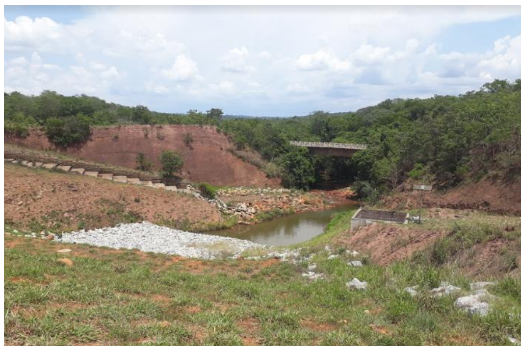
Figura 19 – Barragem de Acumulação da Represa do Ribeirão Pari II
