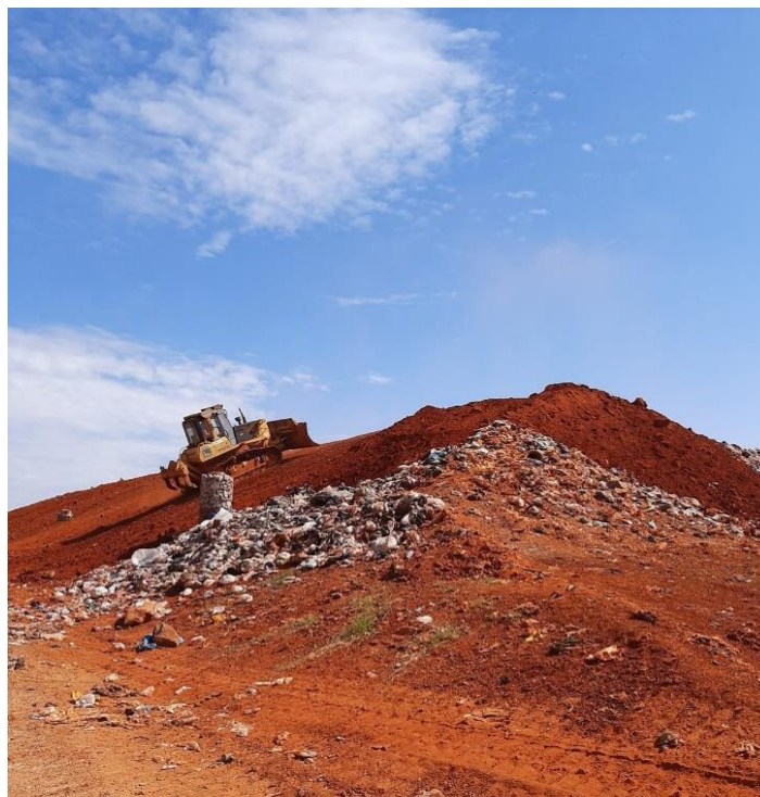
Figura 112 – Taludes do aterro (I)
