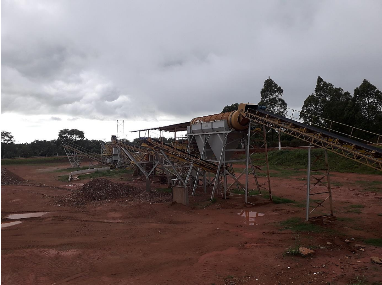
Figura 115 – Usina de triagem de resíduos de construção civil
