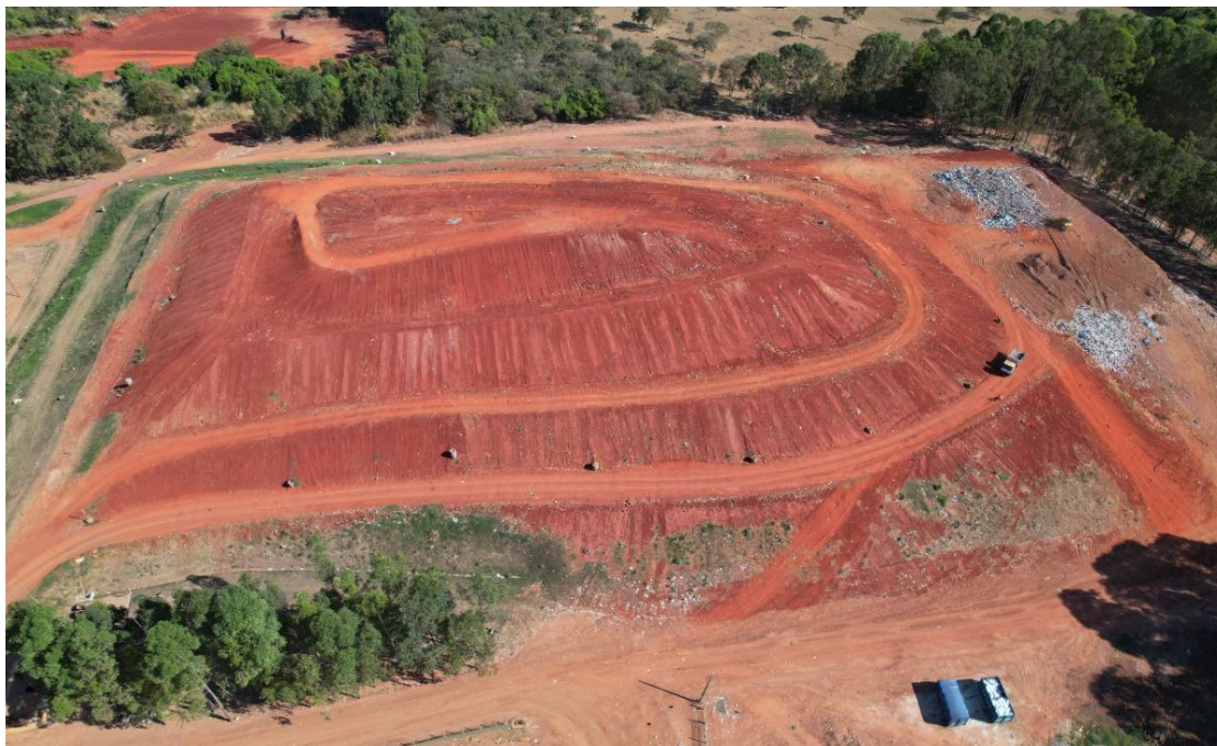
Figura 111 – Taludes de resíduos compactados e recobertos
