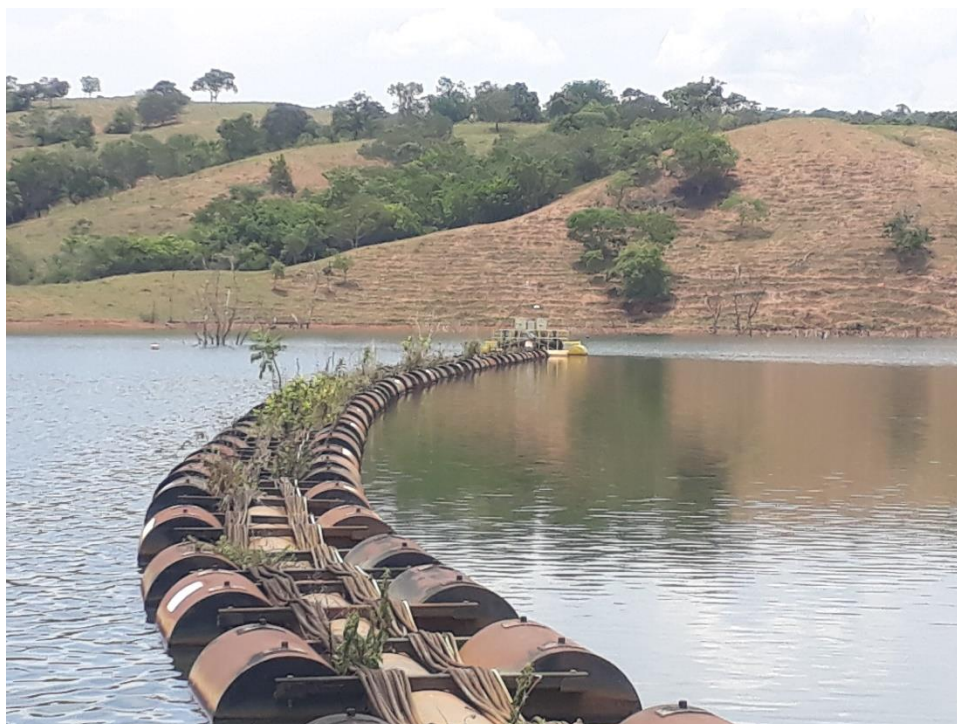
Figura 21 – Captação da Represa do Ribeirão Pari
