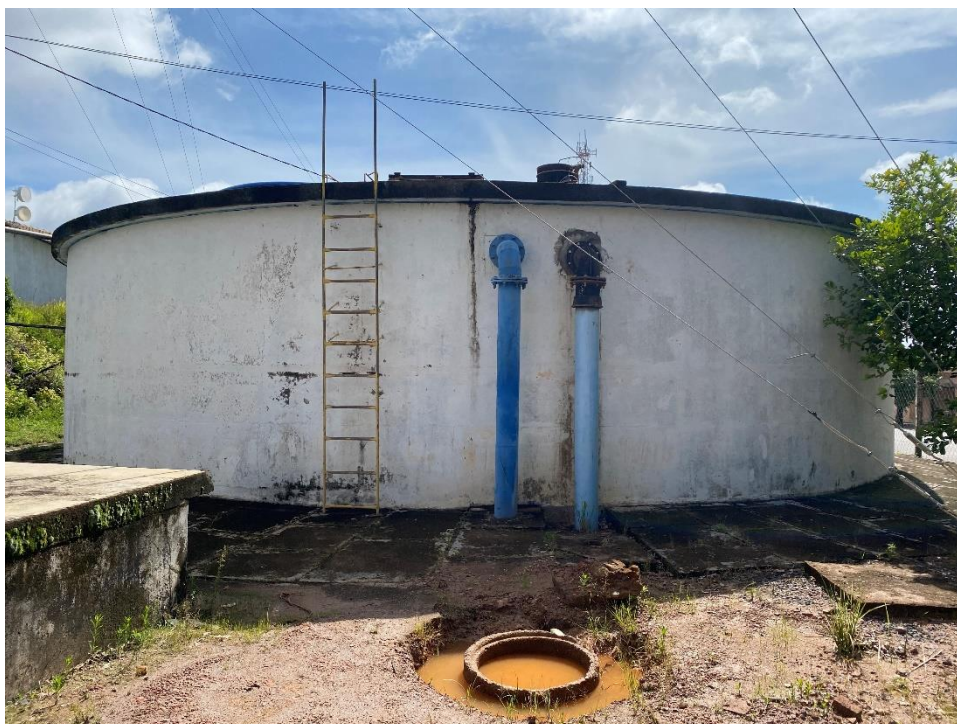
Figura 42 – Reservatório Três Cruzes (Sistema Sede)
