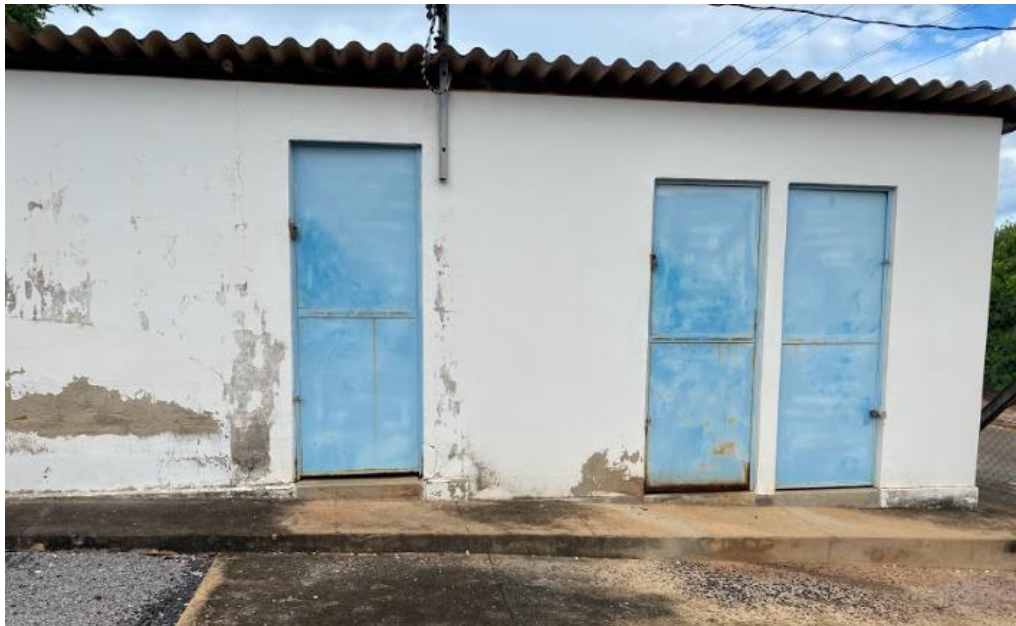
Figura 57 – Casa de tratamento (Pires Belo)
