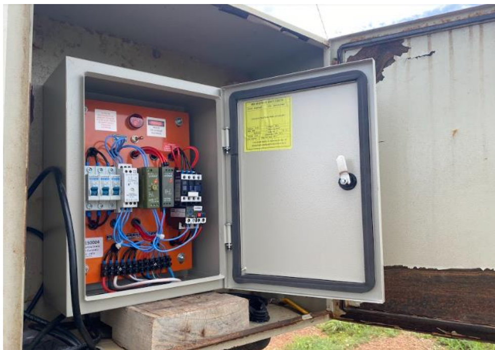
Figura 64 – Quadro de comando Poço da caixa d'água (Sistema Santo Antônio do Rio Verde)
