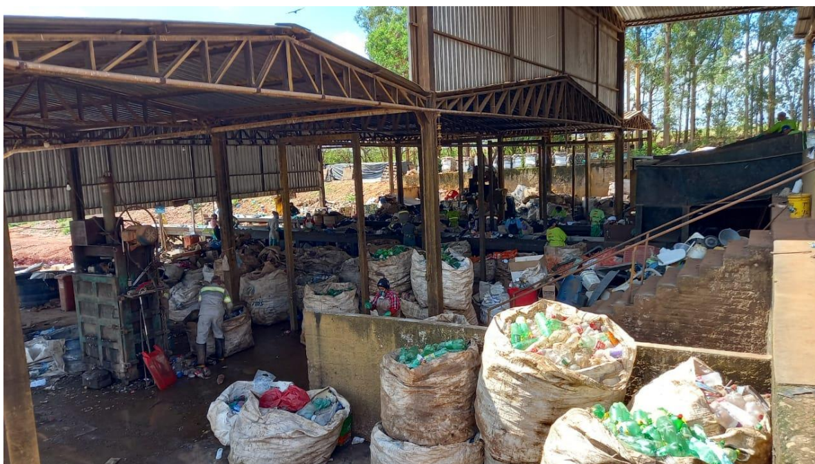
Figura 114 – Usina de triagem de resíduos recicláveis
