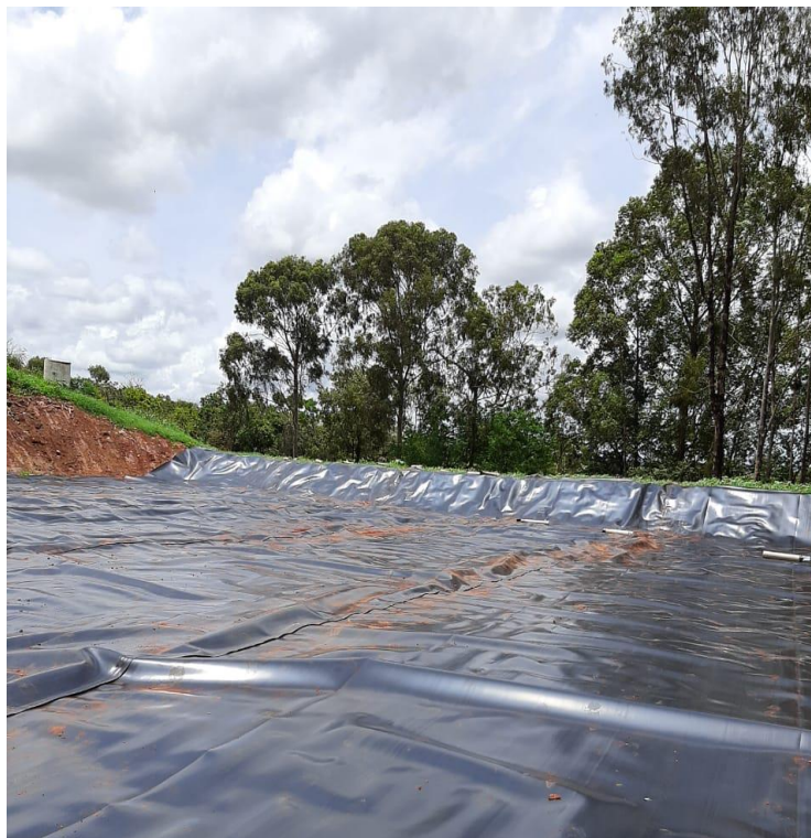
Figura 109 – Impermeabilização da trincheira
