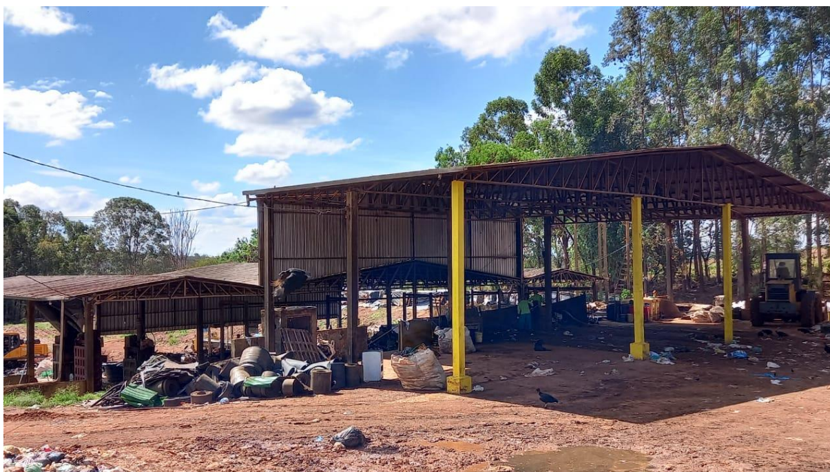
Figura 116 – Galpão da usina de triagem
