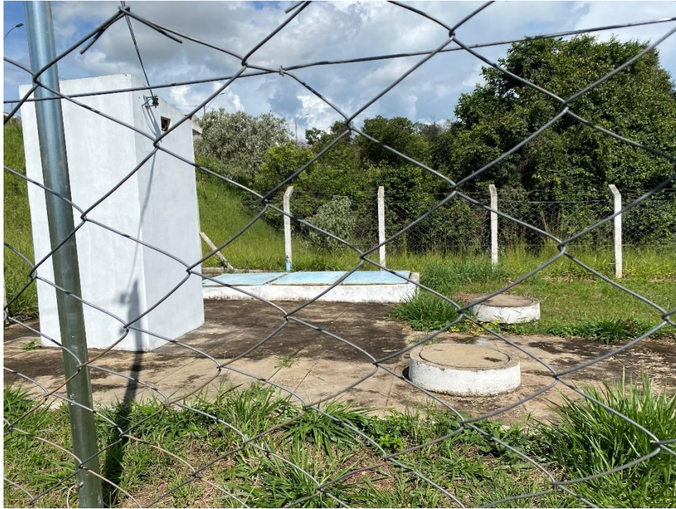
Figura 91 – Elevatória Jardim Itália (Sistema Sede)
