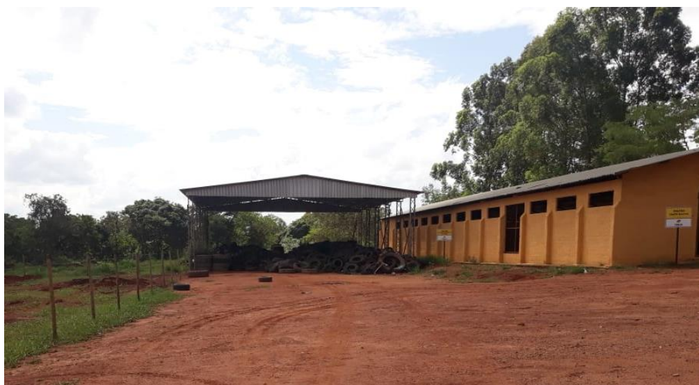
Figura 124 – Galpão para recebimento de pneus
