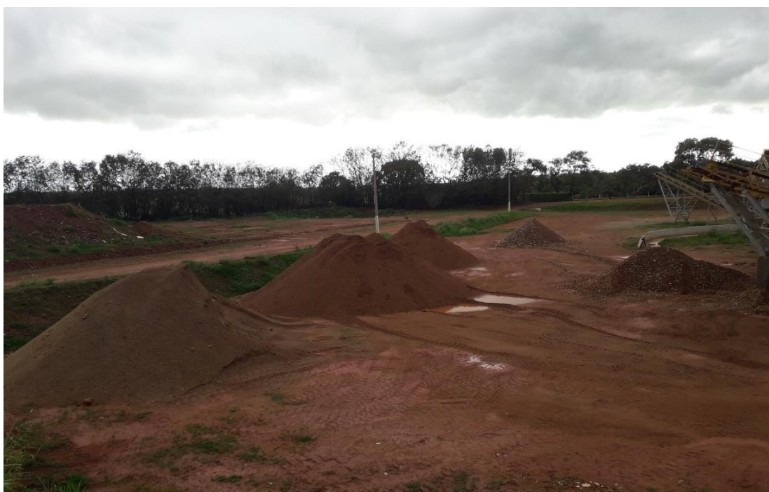
Figura 122 – Produtos da trituração de RCC
