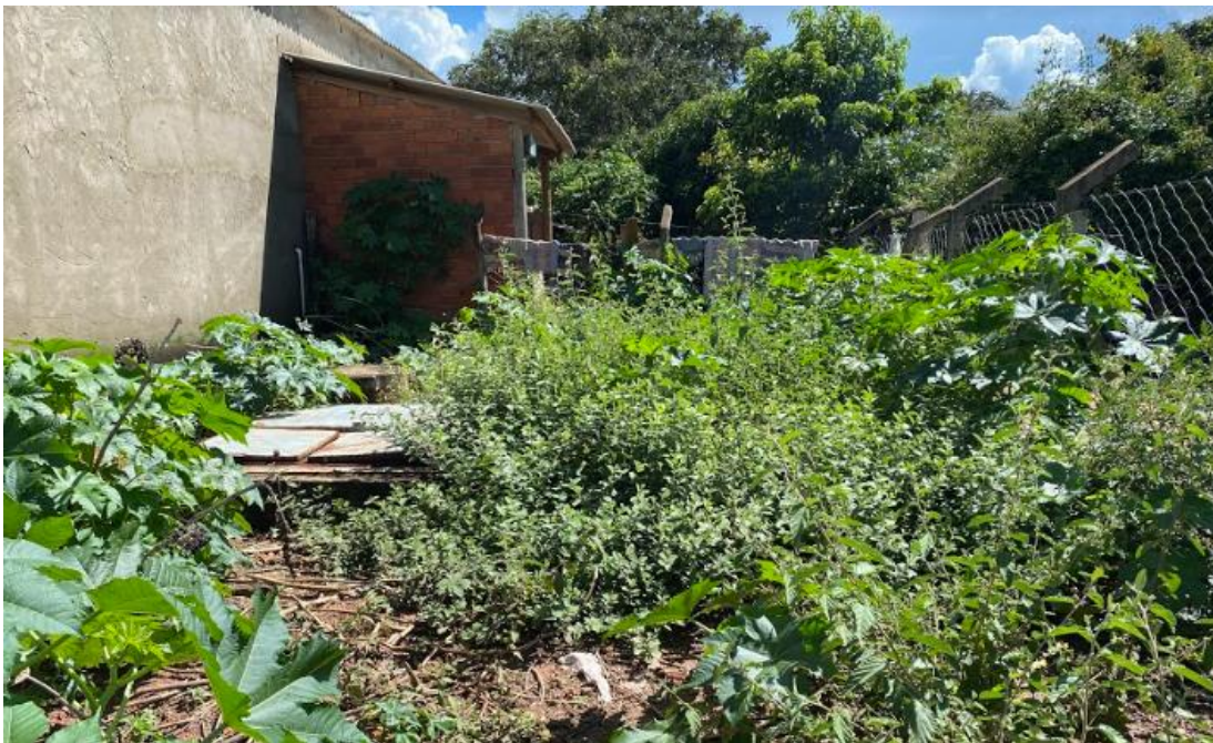
Figura 90 – Elevatória Dona Almerinda (Sistema Sede)
