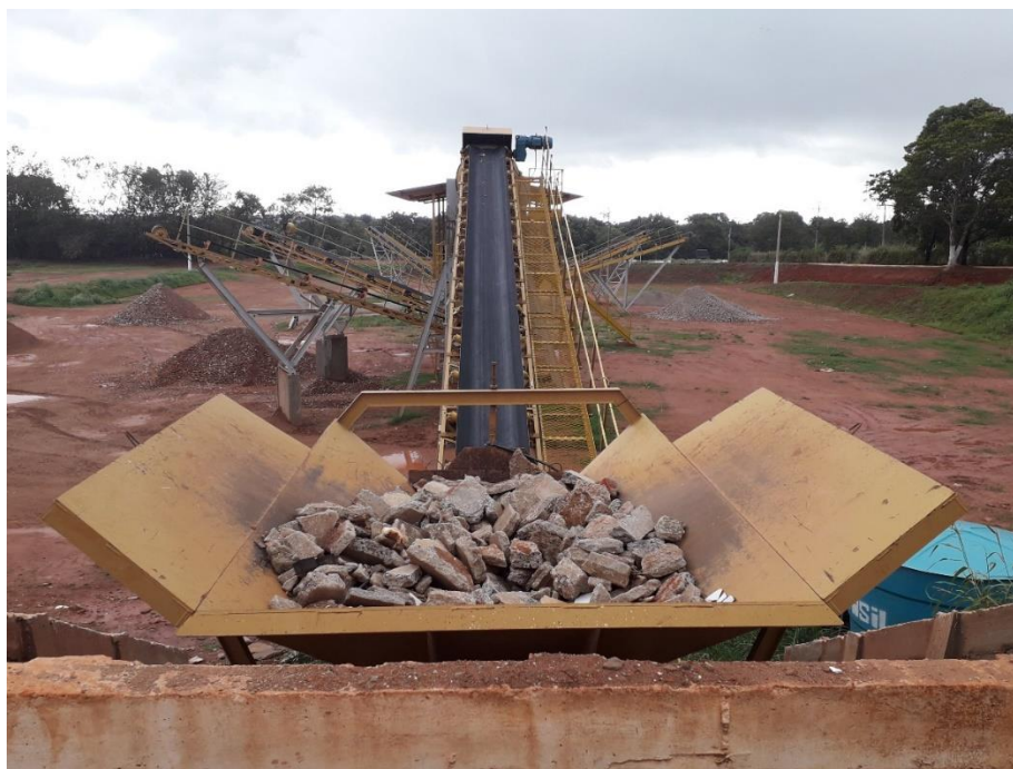
Figura 121 – Usina de reciclagem de resíduos de construção civil
