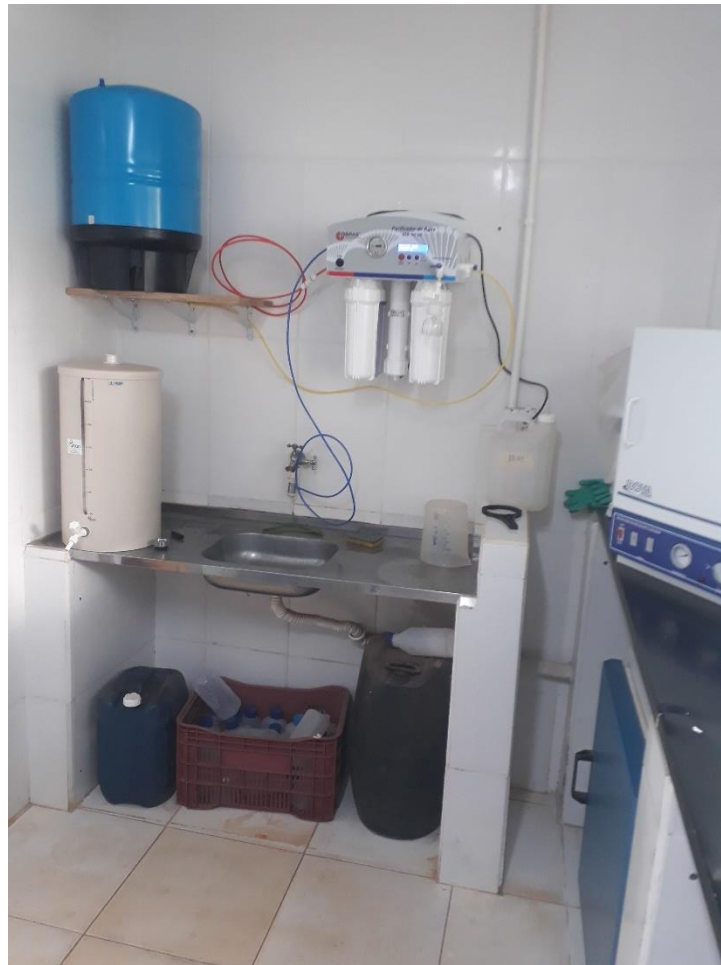
Figura 35 – Estruturas do laboratório da ETA (II)
