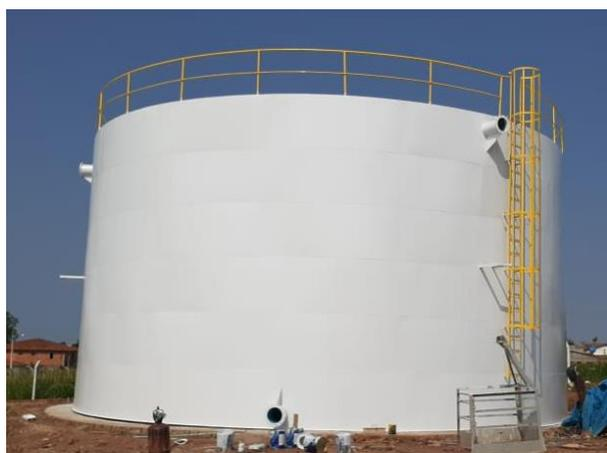
**Reservatório Cilíndrico Fundo Reto Apoiado, Cap.(volume)total: 2000 m<sup>3</sup>;**
