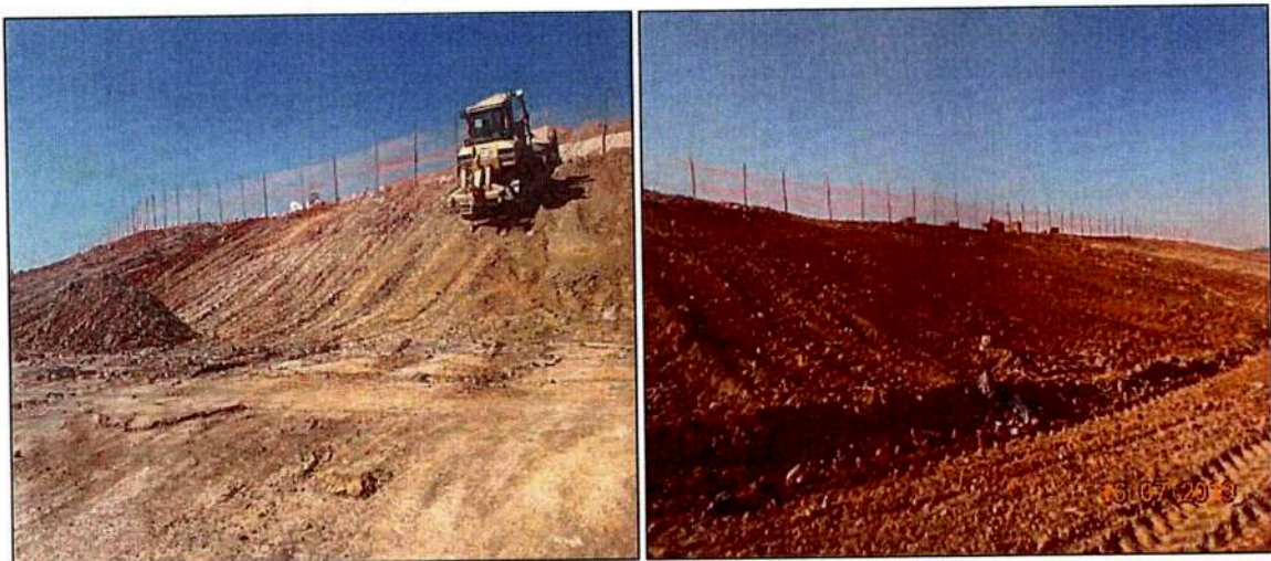
Figura 36 Cercamento com tela da área próxima à frente de operação.
