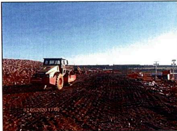
Figura 08 Execução do pátio de descarga da frente de operação
