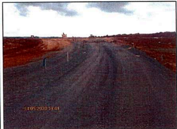
Figura 09 Reforço para pista de acesso à frente de operação
