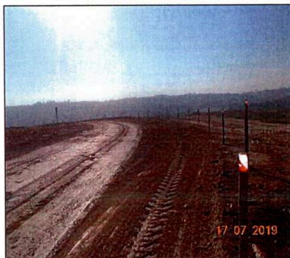
Figura 13 Sinalizadores com fitas refletivas nas vias de acesso.
