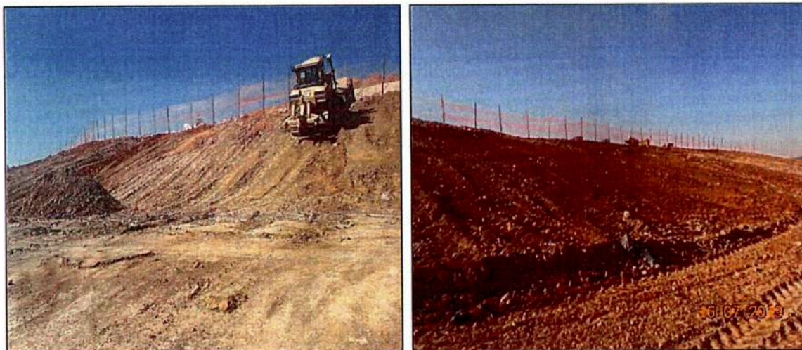
Figura 12 Cercamento com tela da área próxima à frente de operação.
