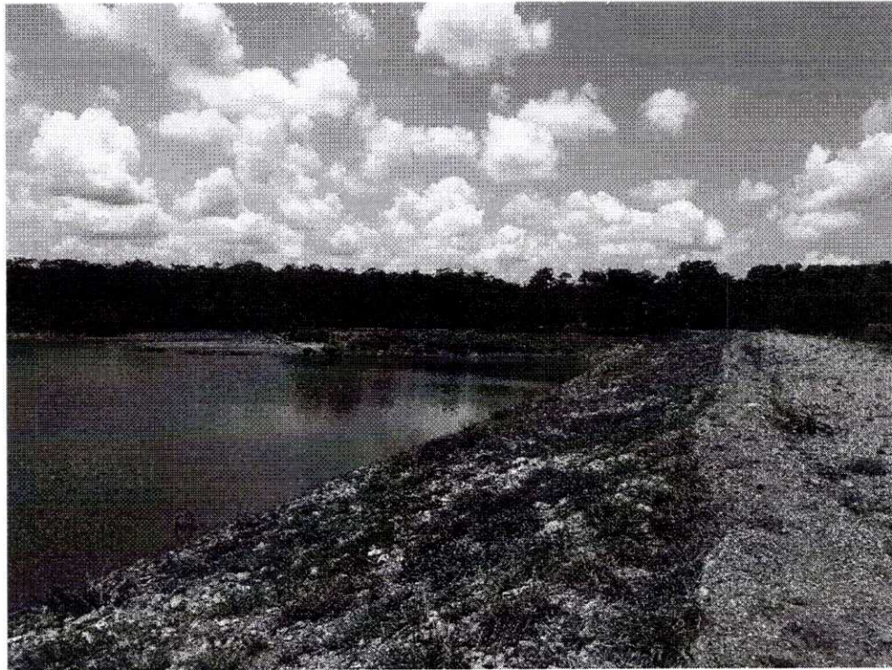
Figura 18 – Barragem de Acumulação da Represa do Ribeirão Pari I
