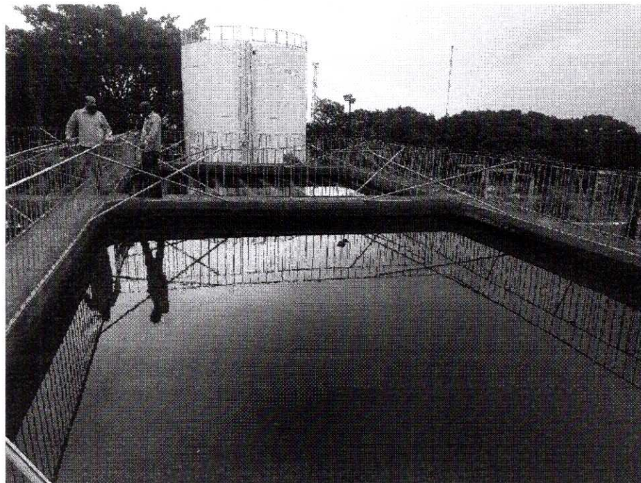
Figura 30 – Decantadores ETA convencional (Sistema Sede)
