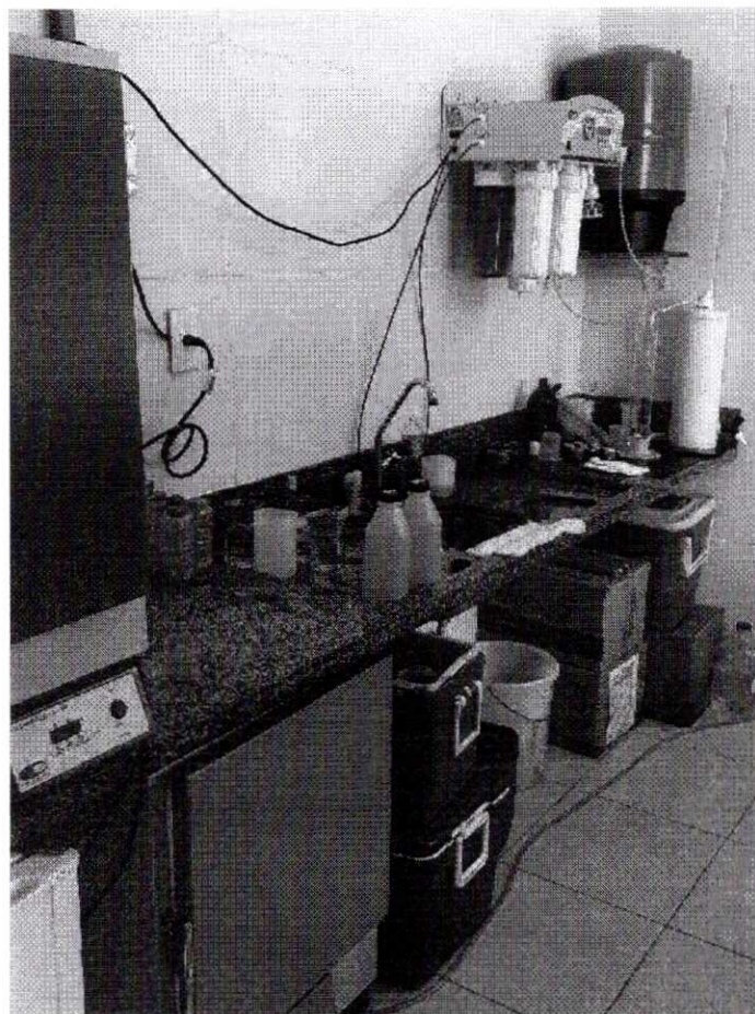
Figura 105 – Vista interior do laboratório da ETE (Sistema Sede)
