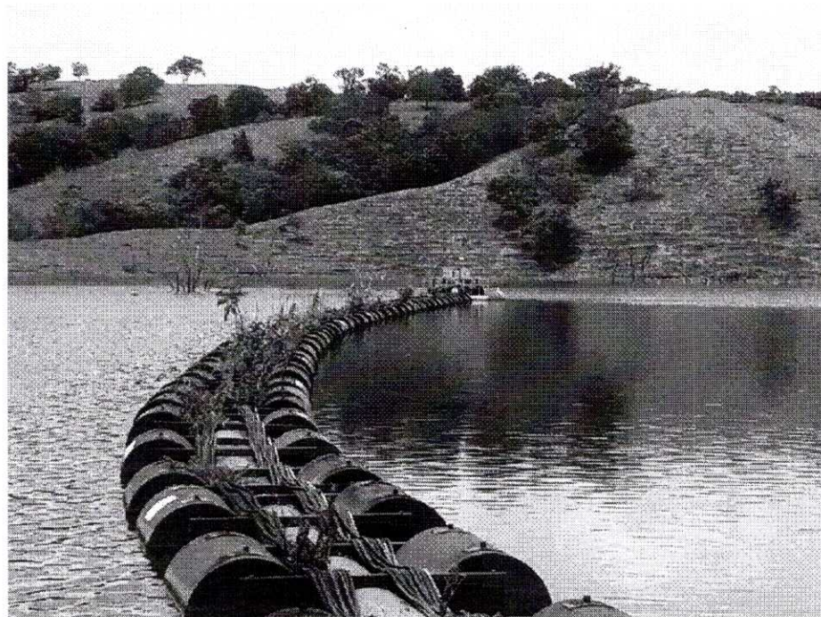
Figura 21 – Captação da Represa do Ribeirão Pari
