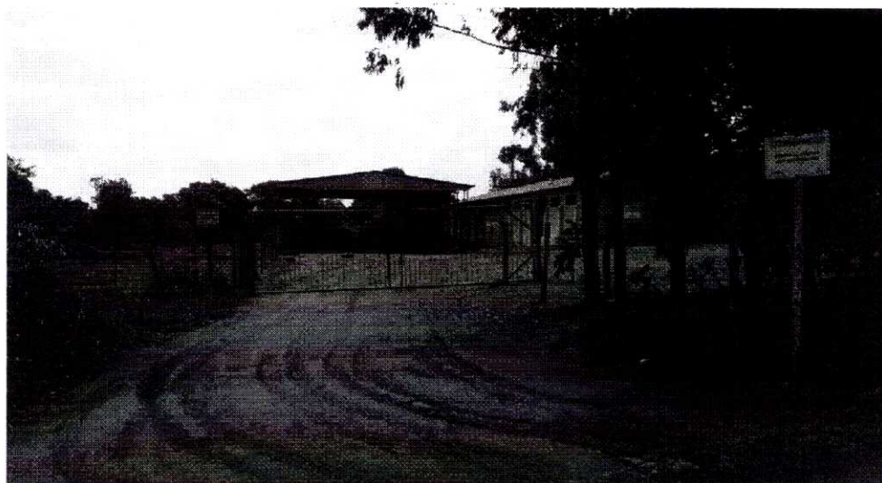
Figura 123 – Galpão para recebimento de pneus
