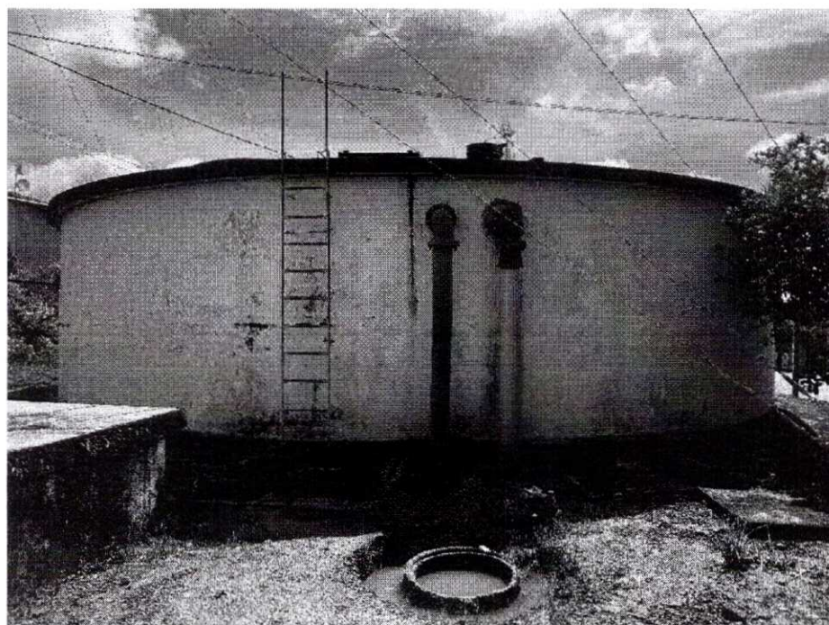
Figura 42 – Reservatório Três Cruzes (Sistema Sede)
