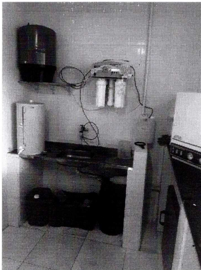
Figura 35 – Estruturas do laboratório da ETA (II)
