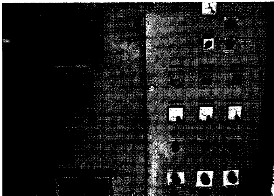
Figura 49 – Quadro de comando EEAT Santo Antônio (Sistema Sede)
