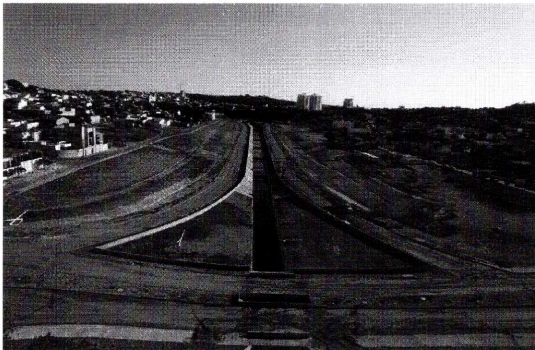
Figura 127 – Etapa final das obras de canalização do Ribeirão Pirapitinga
