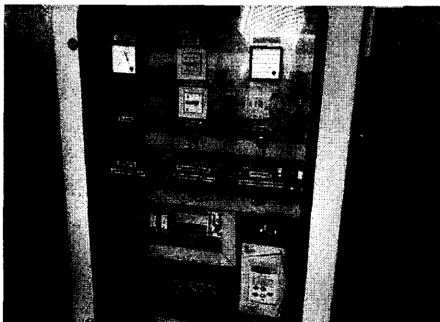
Figura 51 – Quadro de comando EEAT Ipanema (Sistema Sede)
