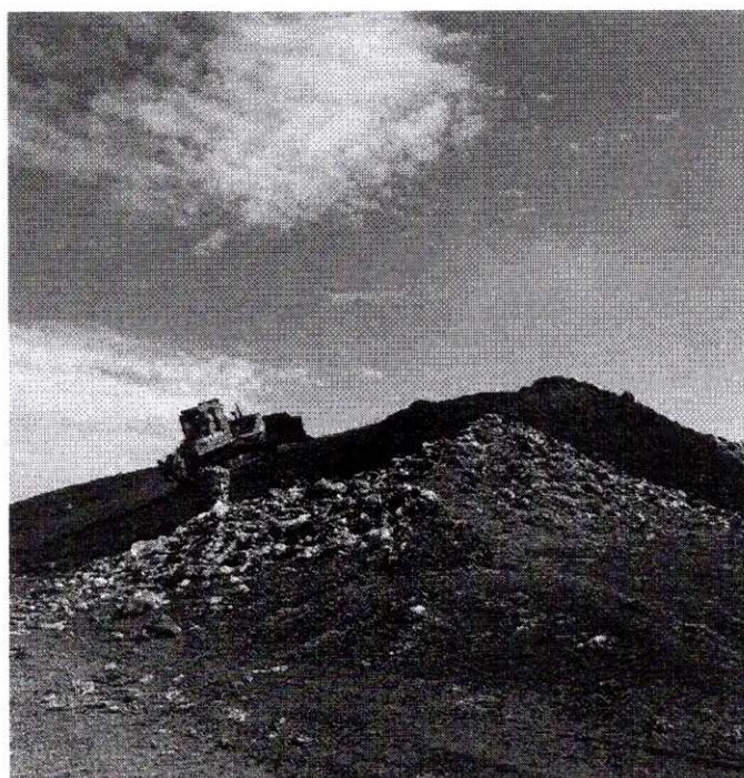
Figura 112 – Taludes do aterro (I)
