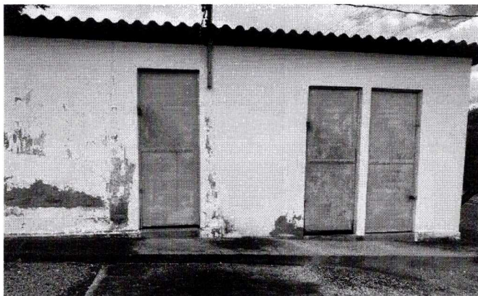
Figura 57 – Casa de tratamento (Pires Belo)
