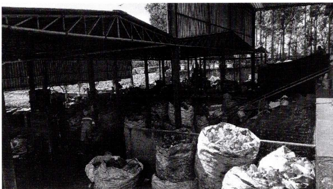
Figura 114 – Usina de triagem de resíduos recicláveis
