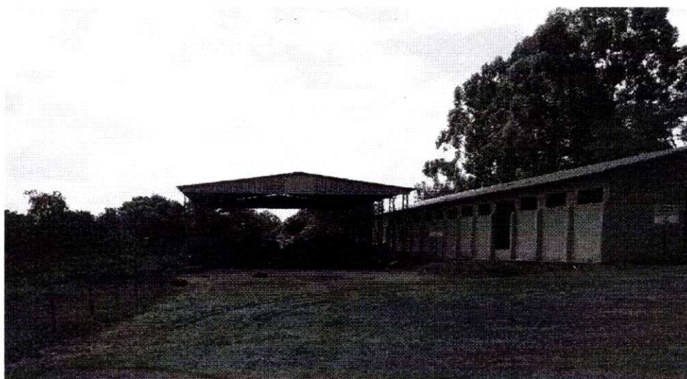
Figura 124 – Galpão para recebimento de pneus
