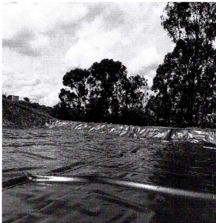
Figura 109 – Impermeabilização da trincheira
