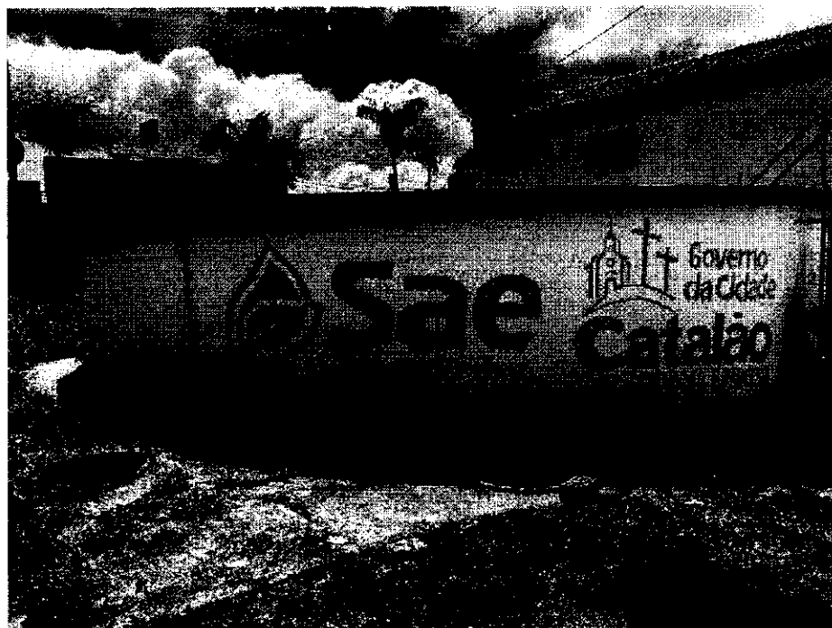
Figura 39 – Reservatórios Clay Mendes (Sistema Sede)
