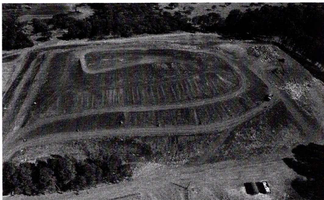
Figura 111 – Taludes de resíduos compactados e recobertos
